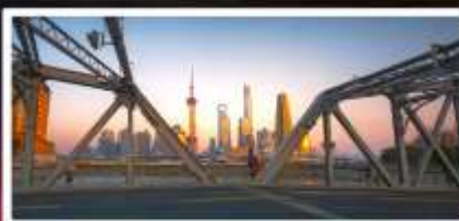
สะพานวอไปตู้
