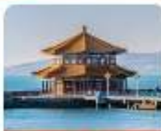
สะพานจางเจียว
